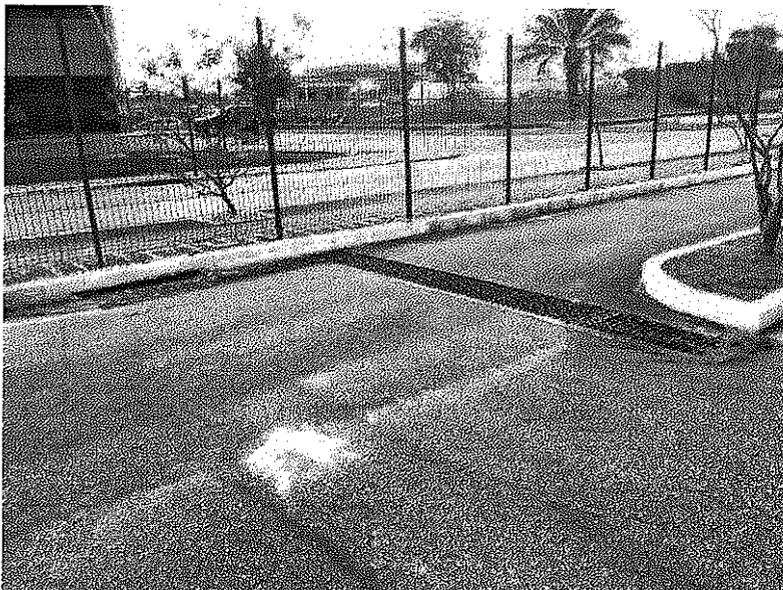
Figura 08: Componentes do sistema de drenagem - canaleta e boca de lobo
